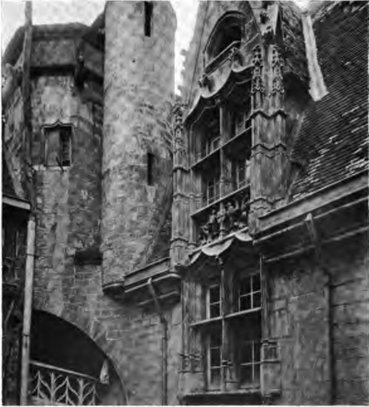
Fig. 88. — Fenêtres et lucarnes superposées à l'Hôtel dit « des Ambassadeurs » de Dijon. xv e siècle.
